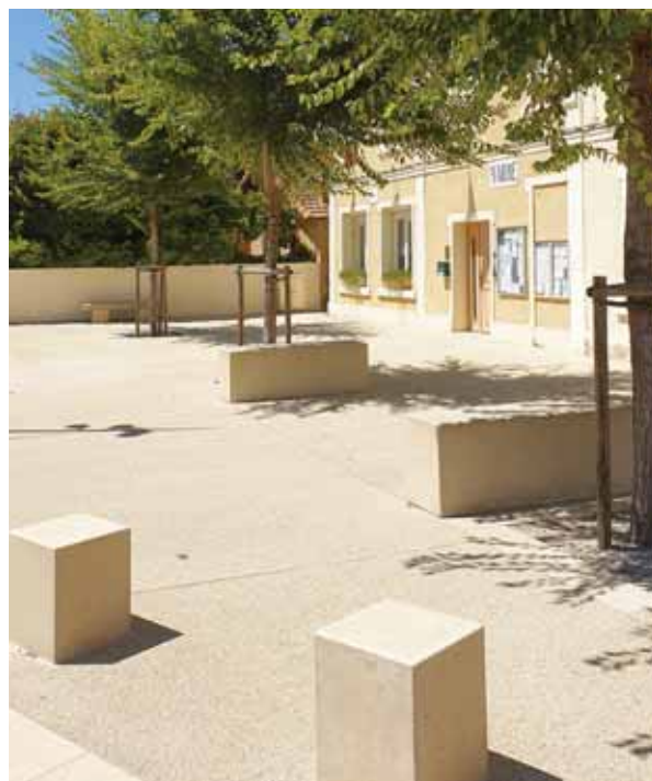
Harmonie de teintes entre revêtement de sol en béton désactivé, éléments de mobilier en pierre et traitement des façades, place de la Mairie (Travaillan)
