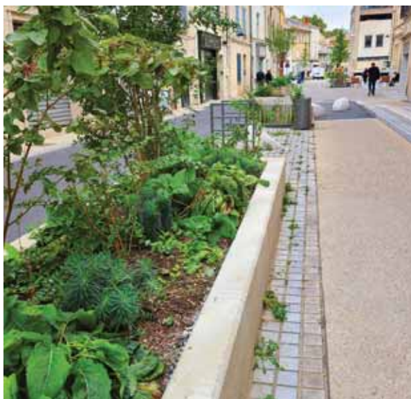
Fil d'eau en pavage pierre, un élément esthétique du dessin de la chaussée
