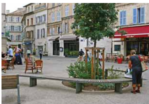
Requalification de la rue Carreterie (Avignon) Aménagement semi-piétonnier récent en zone de rencontre (zone 20 km/h), constitué d'un plateau unique de façade à façade sans bordure ni mobilier de délimitation des circulations véhicules
