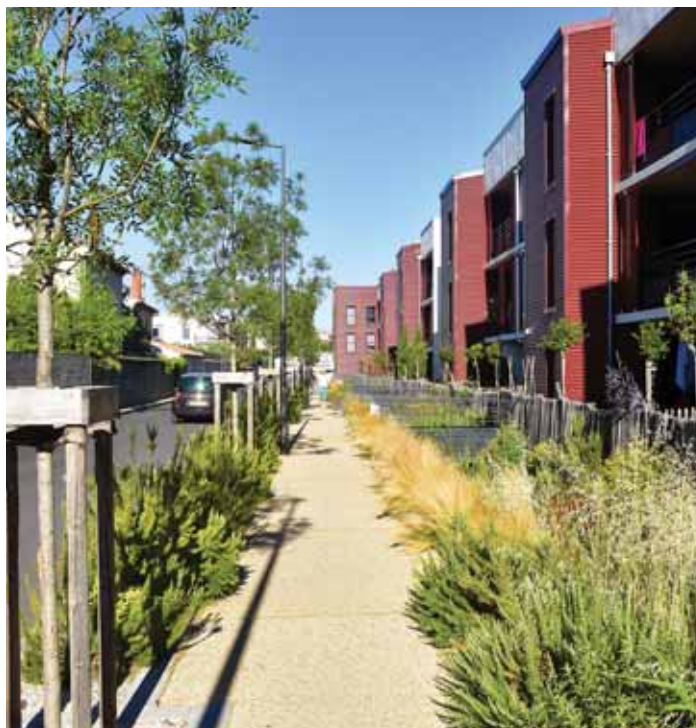
Sols plantés et noue de rétention/infiltration des eaux pluviales en accompagnement d'un cheminement piétonnier public et d'une limite d'espaces privés, Résidence le « Carré Vert » Démarche BDM* *Quartier Durable Méditerranéen (Entraigues-sur-la-Sorgue)
