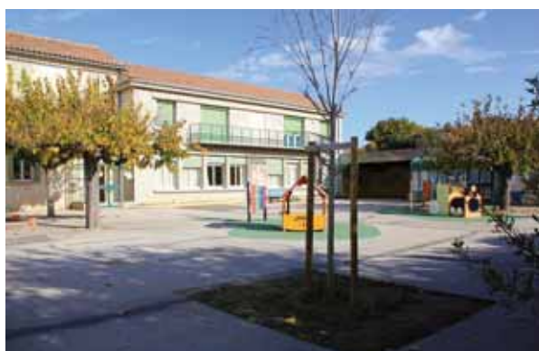
Cours d'école avant travaux ©PNR Luberon (Cabrières-d'Avignon)
