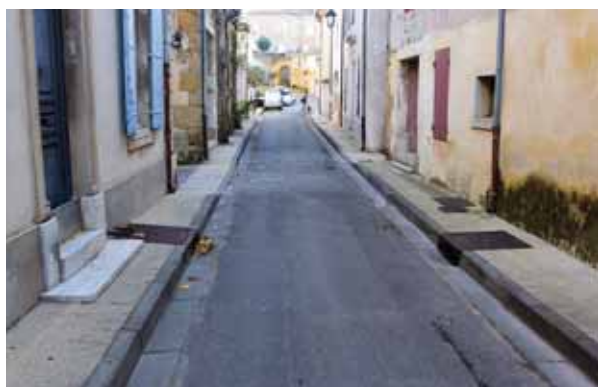
Aménagement d'une ruelle villageoise type année 1960/1970 priorisant la circulation automobile - Chaussée en toit avec fils d'eau latéraux et étroits trottoirs
