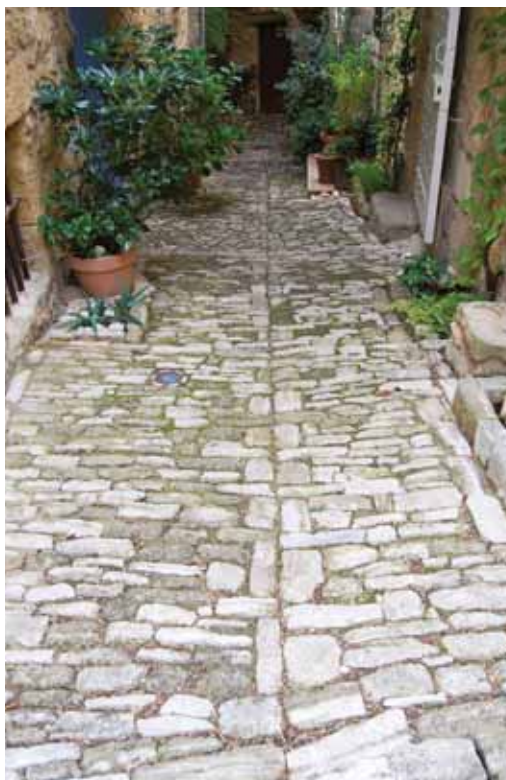
Fil d'eau comme élément esthétique structurant du calepinage d'une ruelle caladée (Ansouis)
